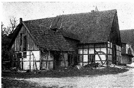
Fachwerkhaus auf den Mauern des Steinhauses
