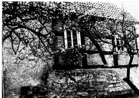
Fachwerkhaus auf den Mauern des Steinhauses
